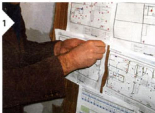
**1** Les plans de l'étude sont affichés sur un panneau. Cela permet une planification précise de l'installation. Une grande rigueur de mise en œuvre est indispensable pour prévenir les erreurs de câblage et/ou de raccordement.
