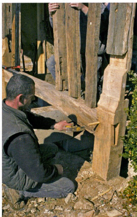
Greffe d'un pied de poteau : Après démontage de l'ancien bois, on prépare le nouveau à l'atelier dans un bloc plein chêne de récupération. La finition au ciseau (goutte d'eau) et les tenons et mortaises sont exécutés et ajustés sur place.
