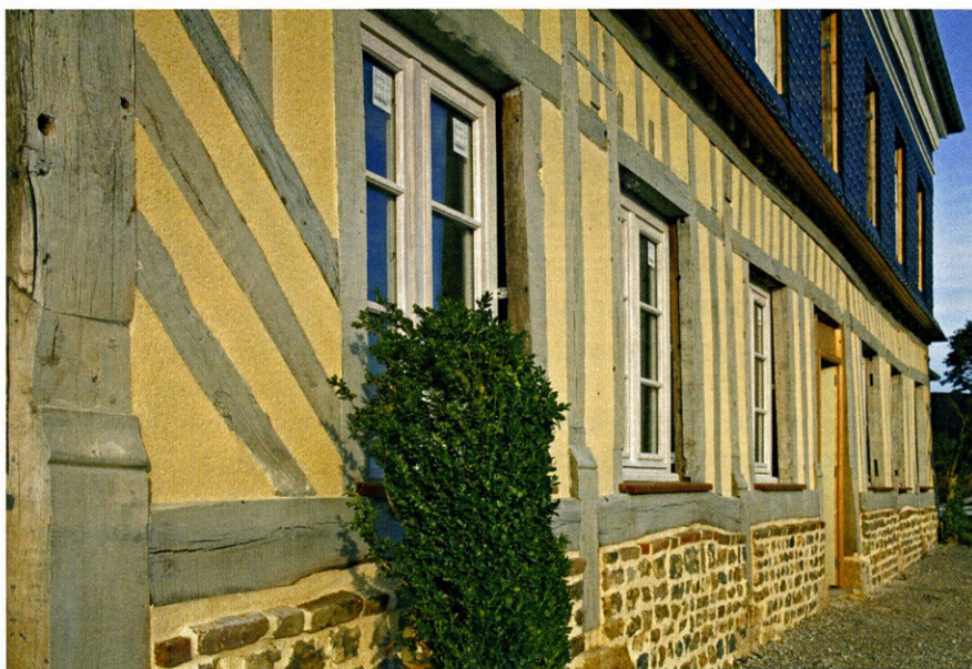
Cette maison acquise en ruine était vouée à la destruction. L'audace de Jacky Barbier en a permis la restauration. Les pieds de poteau changés, les sous-bassement repris à la chaux et un appareillage d'essentes d'ardoises a redonné vie à cette demeure.
