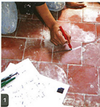
1 Sur le sol, reporter le dessin du décor préalablement réalisé sur papier quadrillé à l'échelle.
