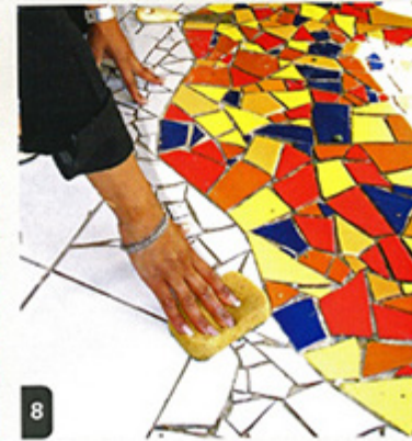
8 Nettoyer parfaitement la surface avant de couler la barbotine qui doit bien remplir les joints.
