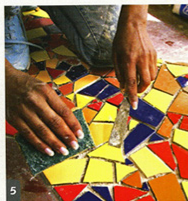
5 Nettoyer la surface des carreaux au fur et à mesure du collage pour que la colle n'y durcisse pas.
