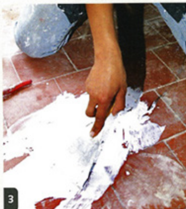
3 Étaler la colle sur le sol, sur une petite surface en commençant par une bordure du motif.
