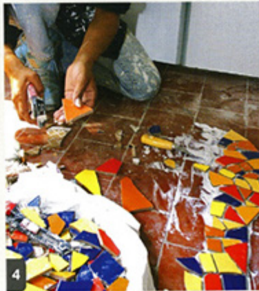
4 Collez les pièces une à une en rectifiant leur format si nécessaire pour qu'elles s'imbriquent les unes dans les autres.
