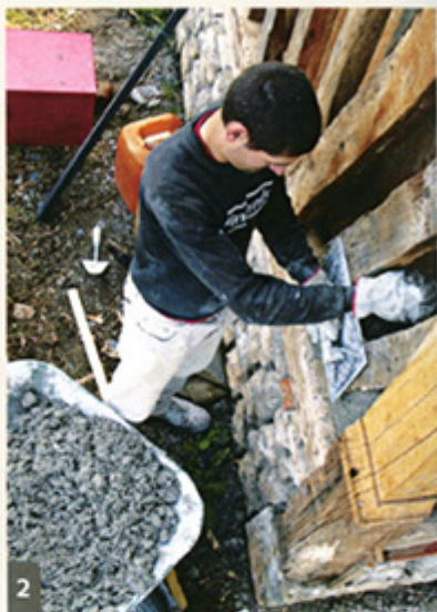
Le béton s'applique à la main pour remplir intégralement les espaces entre les bois.
