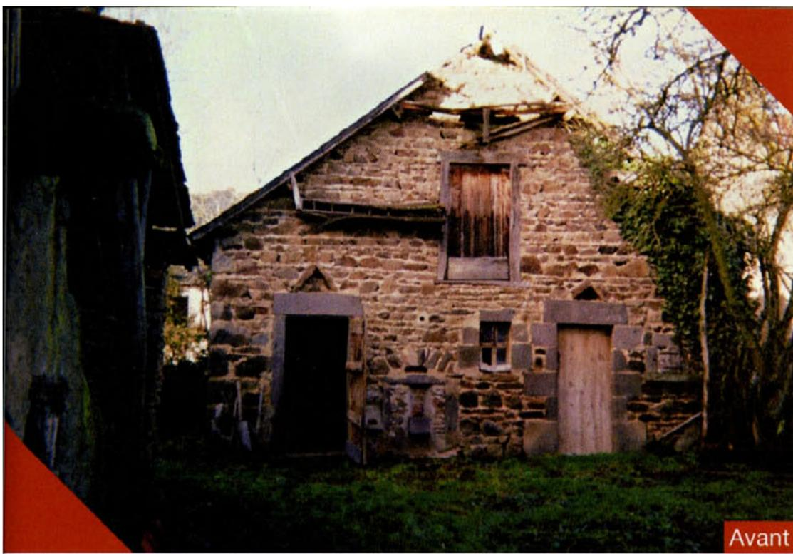
**1. TOUTES LES OUVERTURES D'ORIGINE (ENCADREMENTS EN PIERRE DE VOLVIC) ONT ÉTÉ CONSERVÉES ET VITRÉES (DOUBLE VITRAGE ET JOINT EN SILICONE MASQUÉ PAR DES BAGUETTES EN CHÊNE ET EN QUART DE ROND).**
