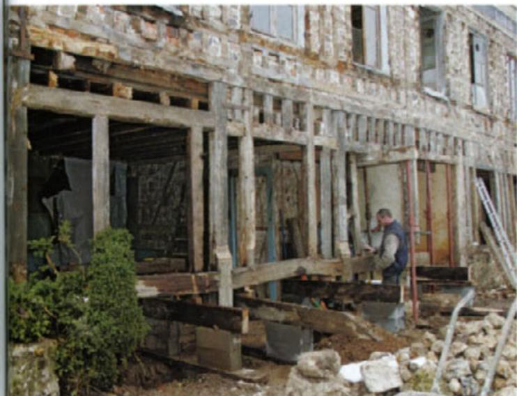
**17** Vue de l'ossature à nu montrant en détail la mise en œuvre de l'ensemble du travail. Tout est calé sur des parpaings, sécurisé avec des étais : on comprend les enjeux de la mise en sécurité.
