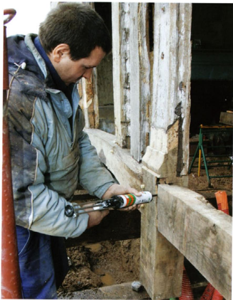
**12** Un ruban de mastic colle néoprène assurera l'étanchéité de l'assemblage, il est lissé et après séchage l'excédent sera arasé puis teinté, devenant totalement invisible.
