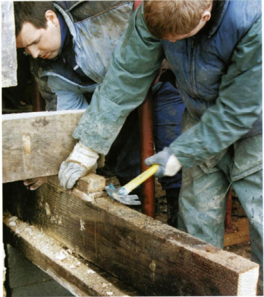
**6** On soulève en faisant bras de levier à l'aide d'une barre à mine, plusieurs étais ont été disposés judicieusement, les tenons des verticales sont engagés dans la sablière et des coins enfoncés au marteau calent le dispositif.
