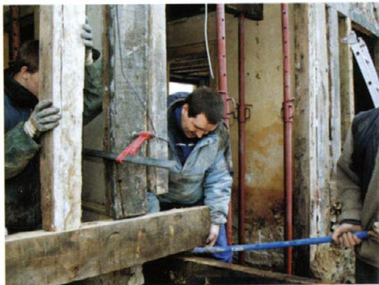
**5** Au fur et à mesure de la mise en place de la sablière ou sole, on fixe à blanc à l'aide de presses de grande tailles. À en juger par les attitudes des poseurs, il faut forcer.
