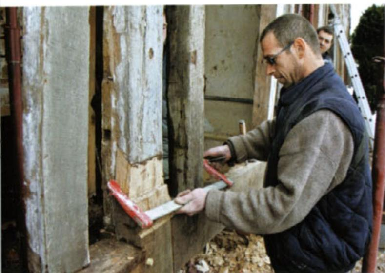
**4** Avant la fixation définitive qui se fera par tenon et mortaise, il convient de peaufiner la mise en place, et ce n'est pas rien. En effet, ce qui a été réalisé par prises de cotes doit maintenant être ajusté sur pièce.
