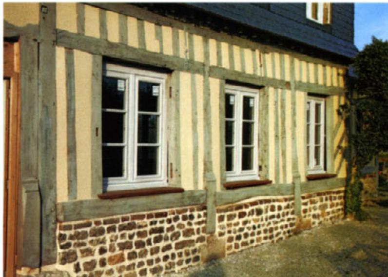
**18** Sous le même angle, en phase finale, l'effet avant après est frappant. Un débordement à la base de l'essente d'ardoises éloigne les ruissellements des eaux de pluie protégeant ainsi soubassement et colombage.
