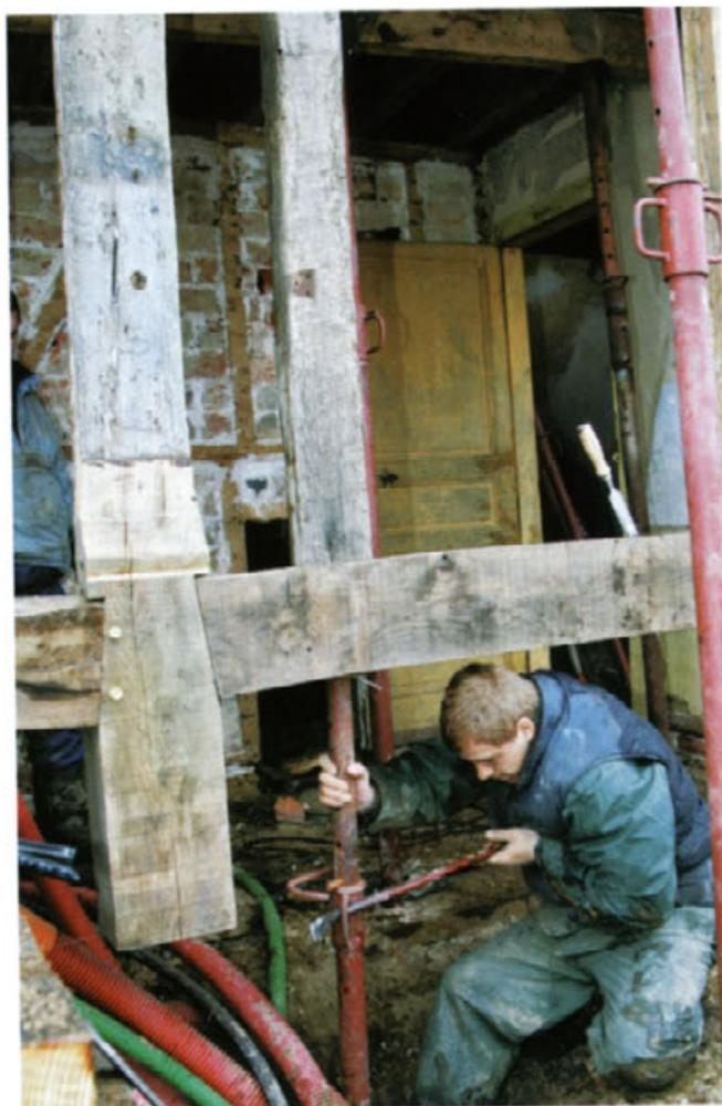
**11** Conjuguant prise de cote et contrôle du niveau, le serrage ou desserrage de l'étau permet d'ajuster avec la plus grande précision. L'étau est appuyé en bas sur le béton de fouille.
