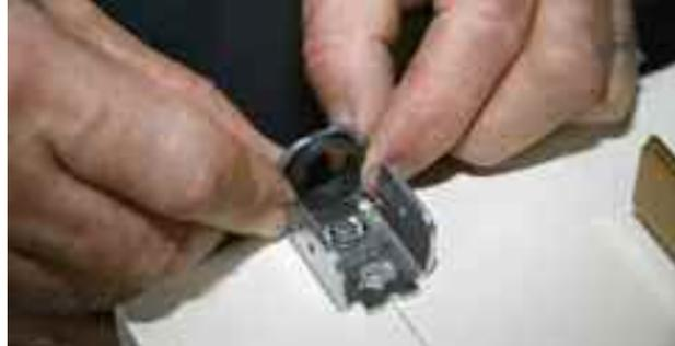
**20** Fixer les guides pènes inférieur et supérieur et les aligner respectivement en se calant sur les chants haut et bas de la porte. Y loger les coussinets destinés à rendre fluide le guidage des tringles.
