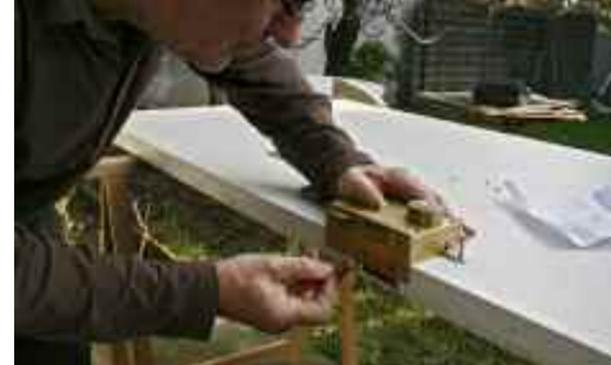
**11** On met en place la serrure pour définir l'emplacement de la têtière du coffre principal. À noter que le mode d'emploi anticipe à tort le positionnement de la gâche principale, car la porte est démontée, ce sera à faire ultérieurement.
