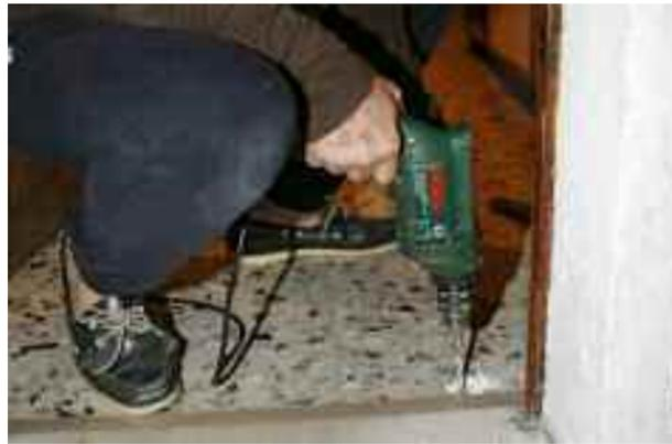
**29** Le gros trou de 25 mm est ici réalisé en faisant plusieurs trous à l'aide d'une perceuse de puissance moyenne et un foret à béton de 8mm. On a tracé l'extérieur du trou au sol à l'aide d'un crayon et en utilisant la gâche tubulaire comme gabarit.
