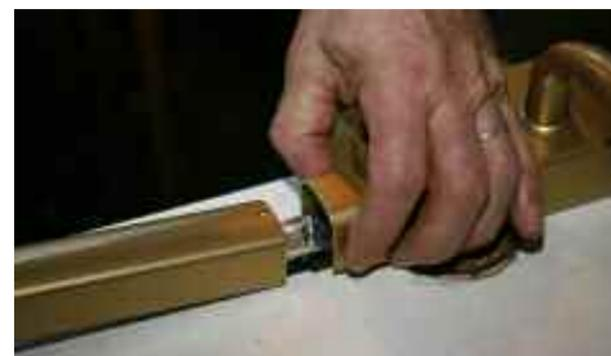
**25** On présente les chapiteaux contre la serrure, ils cachent la liaison des platines, et on fait coulisser les caches tringles en les engageant sous le chapiteau, on peut aussi positionner les caches tringles et clipser les chapiteaux, attention à force, ils se tordent !
