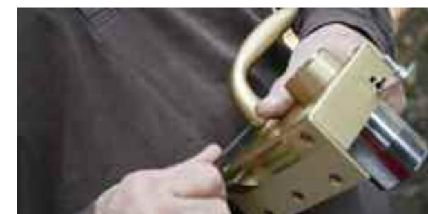
**15** Positionner la tige carrée dans la serrure et fixer la béquille avec la vis pointeau, le serrage se fait à l'aide d'une clé allen non fournie.
