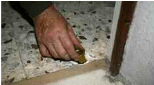
**30** On perce sur 31 mm puis avec une pointerolle on extrait le morceau central, on affine le rond au ciseau à béton. Présenter à plusieurs reprises pour affiner l'ajustage de la pièce, On la collera, porte fermée verrouillée.
