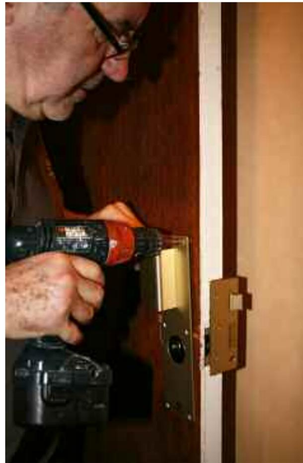
**32** Le système de sécurité est livré d'origine avec un petit cache rond assorti à visser sur la porte, on a privilégié ici un habillage plus conséquent et doté d'une poignée, assorti également. Il se fixe à l'aide de vis têtes fraisées.
