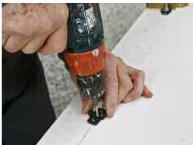
**19** Fixer les platines intermédiaires par le trou central, en suivant les cotes de positionnement indiquées sur le mode d'emploi relatives à la taille de la porte.
