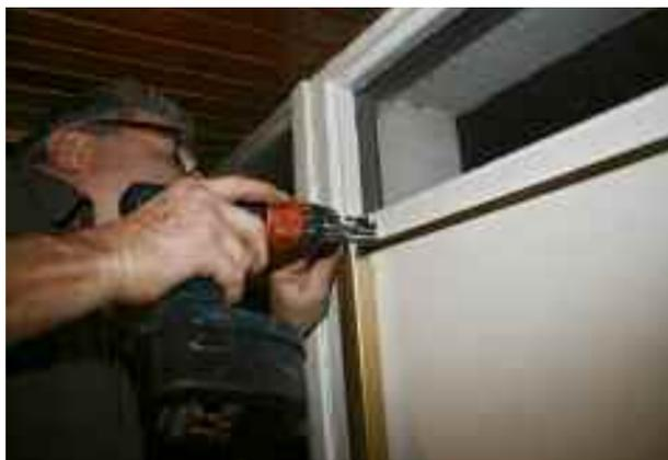
**31** Positionner la gâche supérieure, on peut la centrer par rapport au pêne supérieur, également en verrouillant la porte, on la décale de 3 mm vers le haut et on la fixe avec les vis.
