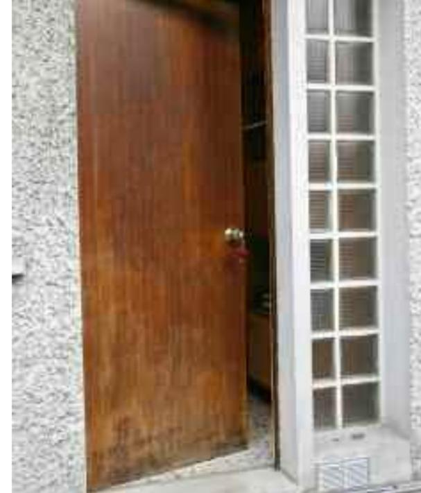
1 Abimée en partie basse mais seulement superficiellement, cette porte en chêne posée en 1965 a bien résisté aux intempéries. Le système de protection a besoin d'être sécurisé pour satisfaire aux assurances.
