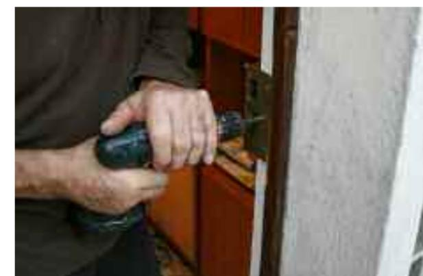
**28** On entaille l'emplacement de la têtère de la gâche principale sur 3 mm de profondeur. Pré-percer les trous de fixation de la gâche principale à l'aide d'un foret de 2 mm, puis on les fixe à l'aide des vis têtes fraisées fournies.
