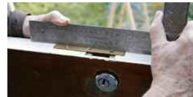
**14** Affiner l'entaillage en présentant fréquemment la têtière du coffre principal et en vérifiant l'ajustage à l'aide d'un équerre posé à chant sur la porte. On voit la position de la serrure par rapport aux trous.
