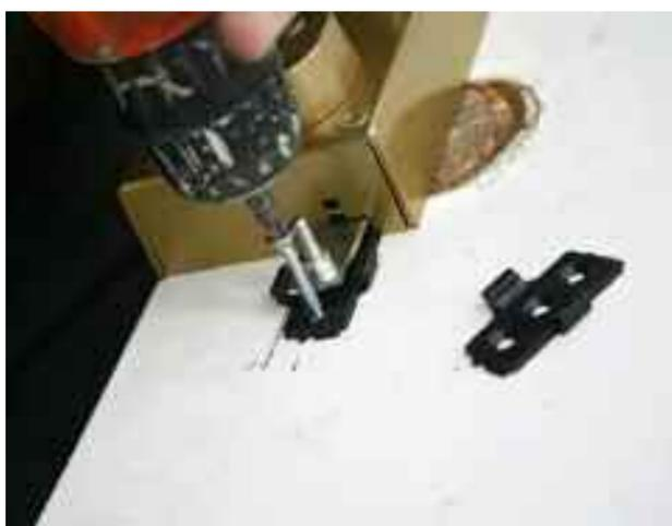
**18** Positionner les platines dans les encoches du coffre, on met la forme déportée du côté du chant de la porte. Pré-percer au foret diamètre 2mm et visser toujours bien droit avec les vis fournies têtes fraisées brut.
