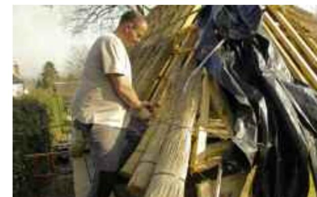
5 La première rangée de bottes ou larmier est installée, serrée au fil de fer galvanisé entre la tige métallique galvanisée aussi (ø5,5 mm) et le liteau. La tige métallique caractérise la méthode hollandaise.
