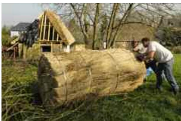
**8** Le roseau utilisé sur ce chantier provient de Camargue, livré en 3 tailles il est acheminé par transporteur, conditionné en roundballeurs, comme on le voit ici les derniers mètres se font obligatoirement à la main.
