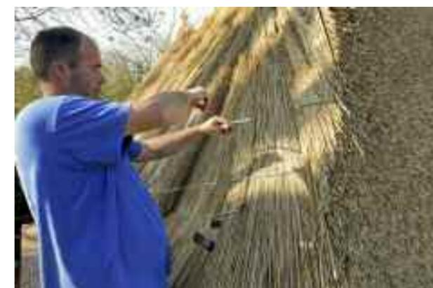
**17** Deux aiguilles métalliques, dont une avec un œillet et l'autre rainurée sont plantées dans le chaume de part et d'autre de la tige métallique visible et du liteau... invisible, l'une rentre dans l'autre guidant le fil de fer.
