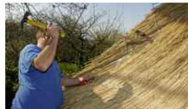
**24** Un serrage puissant est réalisé au marteau, on tire le fil dans le nœud coulant avec une pince en même temps que des coups de marteau sont assésés sur la tige métallique, puis on bride le fil de fer.
