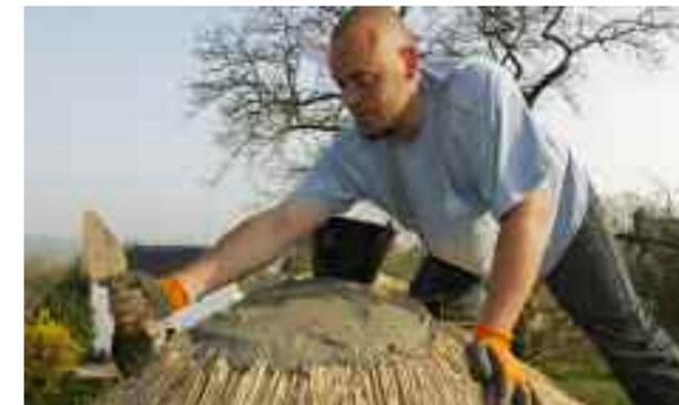
**35** La couche de ciment est étalée à la truelle, le couvreur tapote fermement la tige métallique à l'aide de l'embout du manche de l'outil pour faire descendre le ciment dans et entre les tiges de roseaux.
