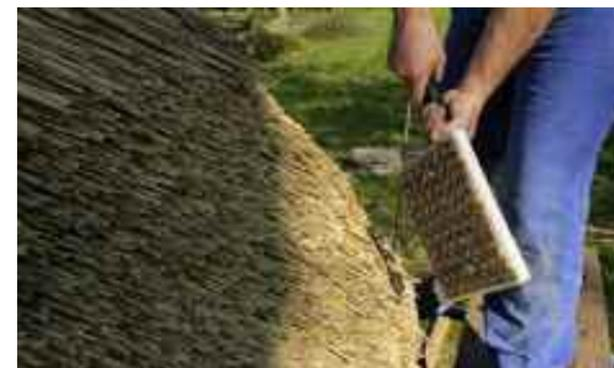
**23** L'effet de lissage assurant la planéité de la couverture s'obtient à la palette, le geste est identique à celui de la main, on remonte toujours du bas vers le haut. C'est avec cet outil que le toit sera démoisé dans 20 ans.
