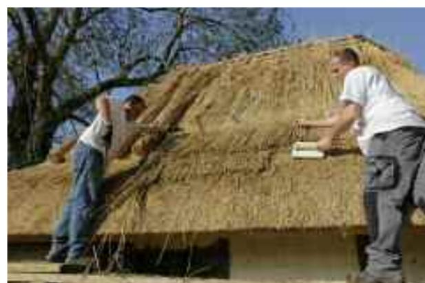
**11** Illustration de la technique pratiquée sur ce chantier ; "à la hollandaise". Les bottes étalées à 30 cm au dessous de la tringle galva du rang précédent, seront "cousues" au liteau par les fils de fer en galva.
