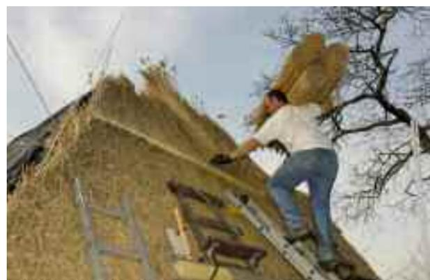
**10** Si le chaumier est seul, il grimpe les bottes à dos d'homme. La photo dévoile les échafaudages du chaumier : échelle en appui sur le versant et tabourets, fixés par deux crocs sur le liteau à travers le chaume.
