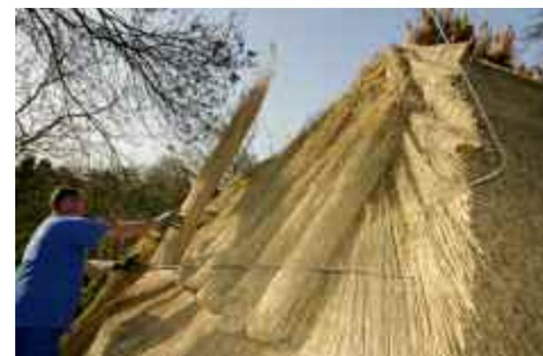
**13** Couverture de la partie supérieure de la croupe, l'arêtier est hérissé du surplus des barres galvanisées du pan de façade, les bottes sont placées grossièrement et seront fixées à 30 cm sous la barre précédente.
