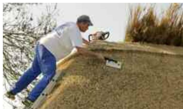
**31** Un rivet (jupette) a été installé sur le pourtour avec l'excédent de roseaux, c'est sur lui que reposera le ciment assurant l'étanchéité et la solidité du faitage. Ce rivet, outre l'esthétique, reçoit les pluviales et protège les roseaux.
