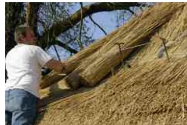
**12** Les barres d'acier galvanisé diamètre 5,5mm, sont raccordées entre elles au fil de fer par chevauchement (20cm). En bout de rang, on replie à la verticale, on se reprendra dessus à l'arête pour garnir croupe et aile de geai.
