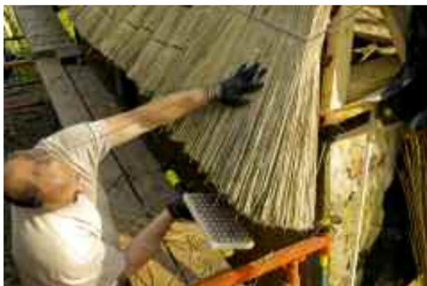
**6** Les premières bottes sont étalées, la hauteur du larmier est réglée aux dimensions de la palette, le démarrage conditionne le succès. Le surplus de la tige métallique recourbée, permettra de se raccorder pour couvrir les croupes.
