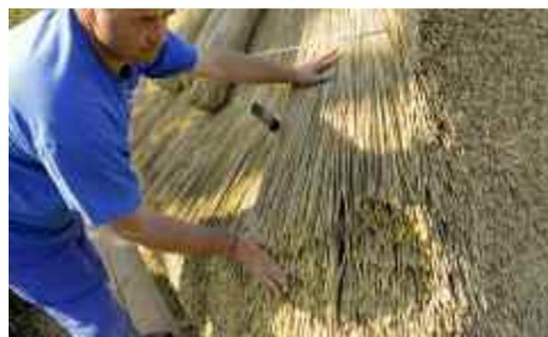
**21** À noter le calage en deux points de la botte en cours de pose, une aiguille bois la sépare de la précédente et à gauche le grand couteau, planté dans le chaume la maintient. On étale en tapotant du plat de la main.
