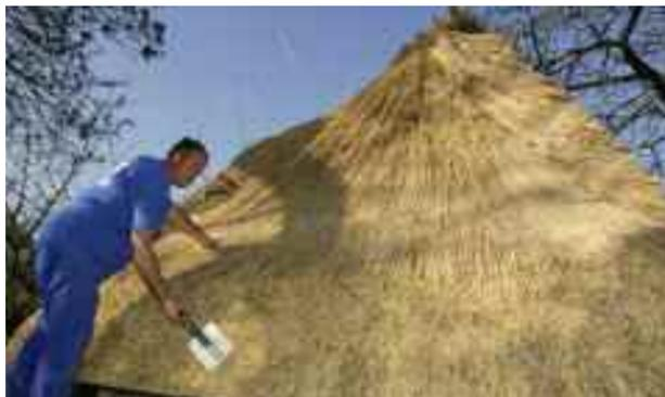
**28** Cette photo montre bien la méthode utilisée par le couvreur, dite « hollandaise ». On est à mi-hauteur de la croupe, de part et d'autre, les arêtes avec, en attente, les tiges galvanisées repliées vers le haut.
