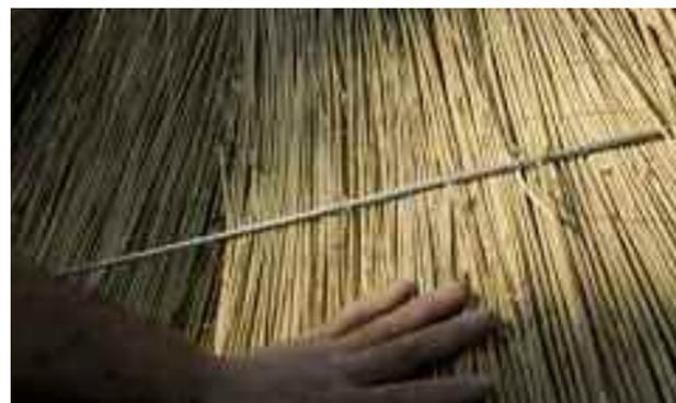
**20** Quinze centimètres séparent les points de fixation, ils sont laissés en attente. Quand la rangée horizontale de roseaux sera fixée, le chaumier serrera fortement au marteau en tirant sur le nœud coulant.
