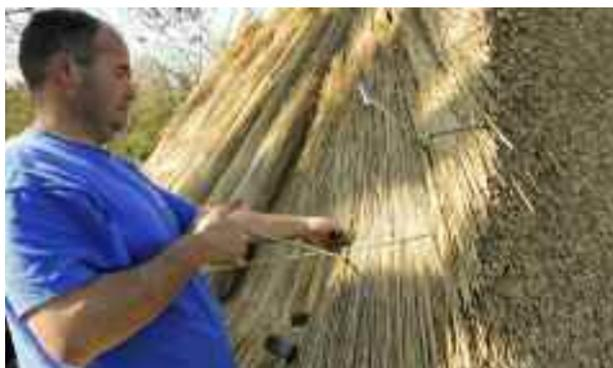
**18** Ayant retiré l'aiguille rainurée, il suffit de tirer l'œillet pour attraper le fil de fer, avec l'habitude trouver le trou de l'œillet, à tâtons derrière le chaume devient machinal, de même pour deviner l'emplacement du liteau.
