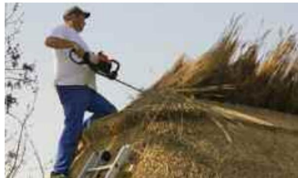
**30** Les "mouquettes" sont arasées horizontalement au taille haie dévoilant l'embout des tiges des roseaux, sur une largeur d'environ 50 cm sur toute la longueur de la toiture. Reste à les protéger.
