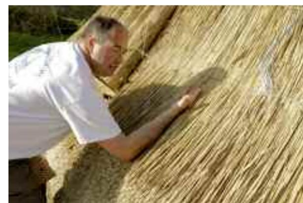
**14** Le chaumier nous dévoile ici ses points de repère et sa méthodologie. En arrière plan on distingue la base du rang de roseaux suivant, le recouvrement de la barre métallique sera bien de 30 cm.
