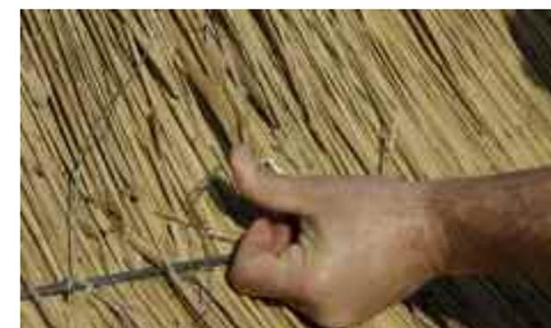
**25** Couverture à mi hauteur de la croupe, on arrive en bout de rangée de roseaux, la barre métallique va nous aider à relier le chaume à l'arête. Celle, en attente pliée à la verticale, va être reliée à celle en cours de pose.
