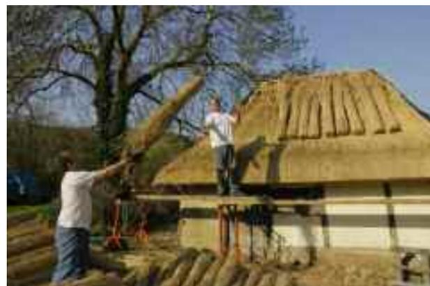
**9** Il faut ensuite grimper la matière première sur le toit, on peut lancer les roseaux, plus facile à exécuter qu'avec une pile de tuiles ou d'ardoises. La photo montrant les rangs successifs décrit bien la méthode.
