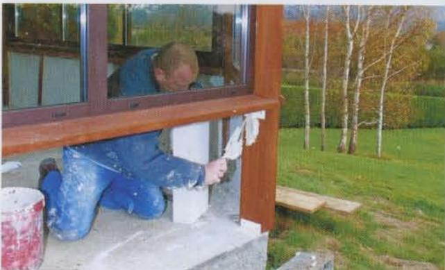
**5** Cette colle spéciale va adhérer à la fois sur les bois vernis, sur la chape en béton brut et sur le béton cellulaire. L'artisan étale largement à la truelle avant de poser la première brique préalablement présentée.
