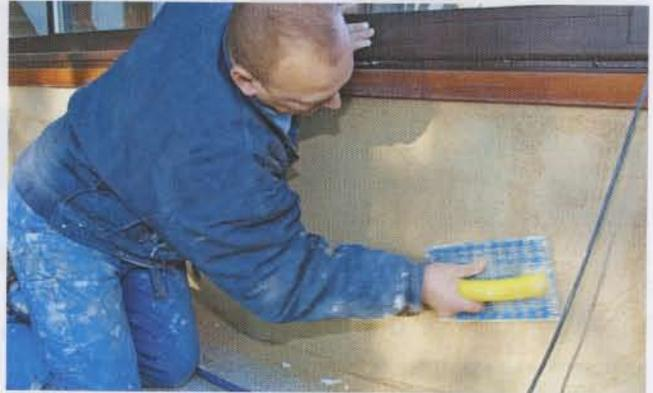
**32** La façade intérieure du muret est recouverte d'un enduit traditionnel légèrement teinté d'ocre. Deux couches sont nécessaires, espacées de 24 heures et serrées à la taloche. Une fois durci, l'enduit est gratté à l'aide de la tranche de la truelle.
