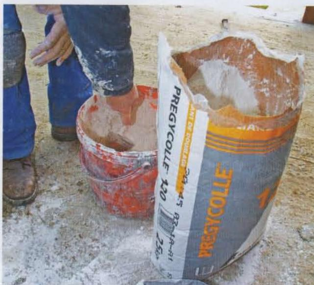
**4** Préparation de la colle spéciale au mélangeur un sac de 25 kg pour 5,5 à 6 l d'eau. On utilise ici un mortier colle Pregycolle 120 : c'est un adhésif à base de plâtre destiné à l'isolation thermique intérieure.
