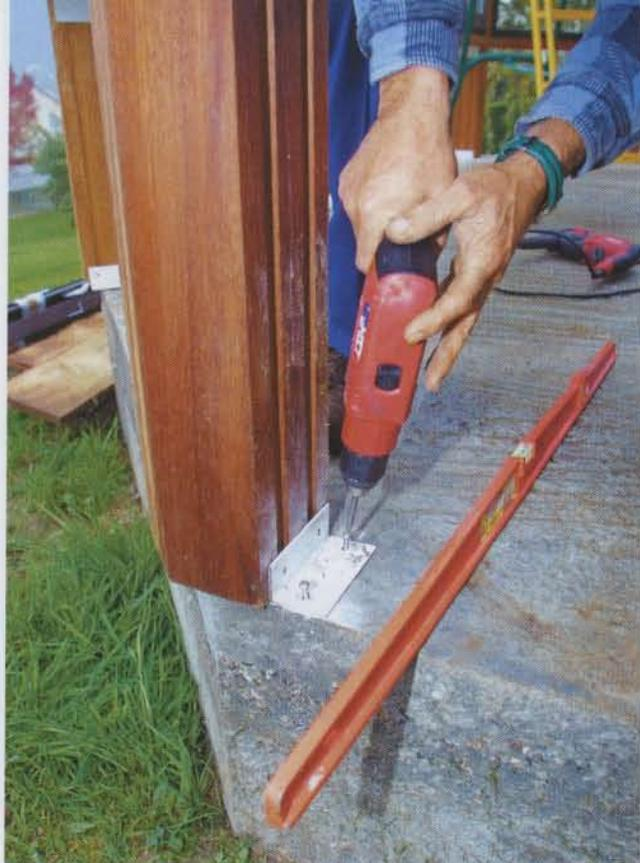
**1** Les poteaux en chêne d'une section de 140 mm x 140 mm sont solidement accrochés à la dalle par des équerres métalliques galvanisées. Ils seront invisibles après montage du soubassement.
