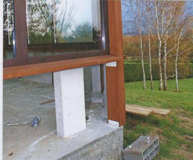
**3** Outre la facilité de mise en œuvre par sa légèreté et les outils nécessaires, le béton cellulaire présente l'avantage d'éviter rigoureusement les ponts thermiques. Format des dalles 62,5 x 50 x 10 cm.
