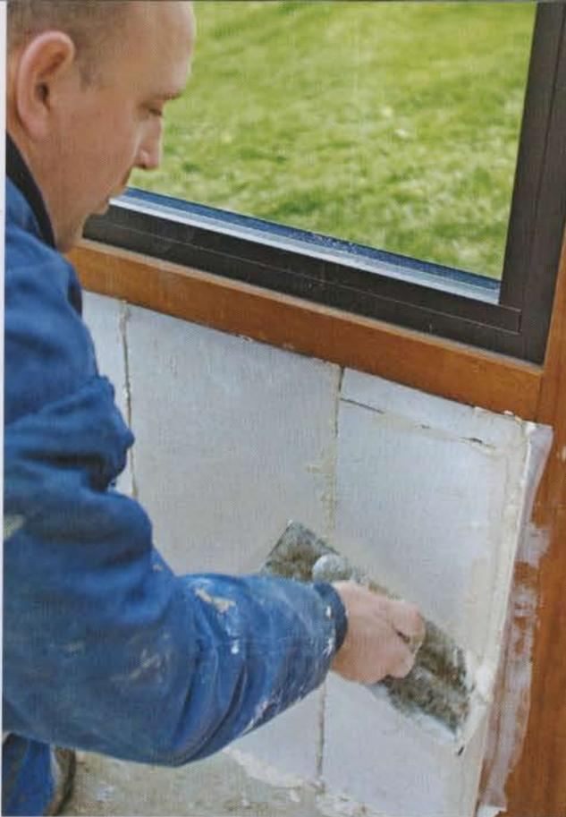
**11** Taloches et truelle feront bon ménage pour raser au plus près l'excédent de colle, cela afin de lisser le mur qui sera recouvert de pierre reconstituée d'un côté et d'un enduit fin de l'autre.
