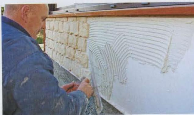
**26** Si possible, humidifier « à refus » le support la veille de la mise en œuvre du produit Sika, puis renouveler sans excès juste avant la pose. Étalez le produit au moyen d'une taloche crantée sur une couche d'environ 3 à 5 mm maximum.
