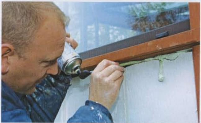
**14** Entre la maçonnerie thermo-pierre et la sole (partie basse des bois sur laquelle repose l'appareillage des colombages), l'isolation et la liaison sont obtenues par application d'une mousse polyuréthane en aérosol.
