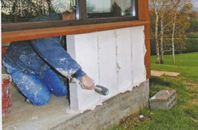
**8** À l'aide d'un maillet et d'un sérieux coup d'œil, le poseur aligne ici les premières briques, on peut également tirer au cordeau pour plus de précautions. À noter la répartition homogène de la colle.
