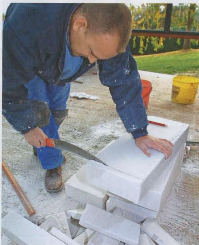
**2** L'âme de ce « vrai faux » solin est en béton cellulaire, sa présence évite les éclaboussures et autres agressions extérieures, ainsi que les chocs résultant de manipulation des meubles à l'intérieur.
