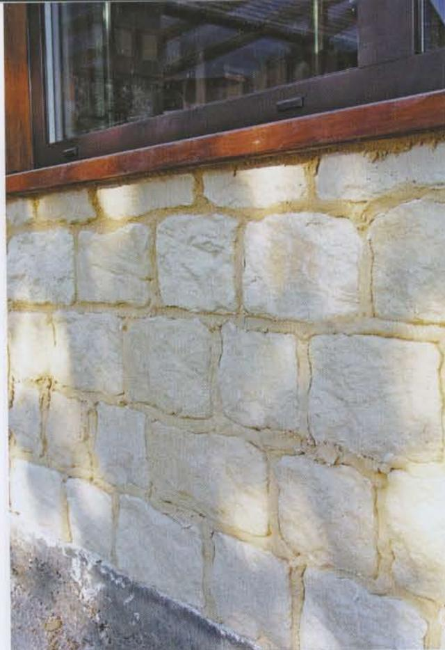
**28** L'aspect avant finition de la face externe du muret habillée de sa maçonnerie de pierres reconstituées présente une bonne homogénéité et une patine assez rustique tant sur le plan modelé que sur le plan du mélange des tons ocres.
