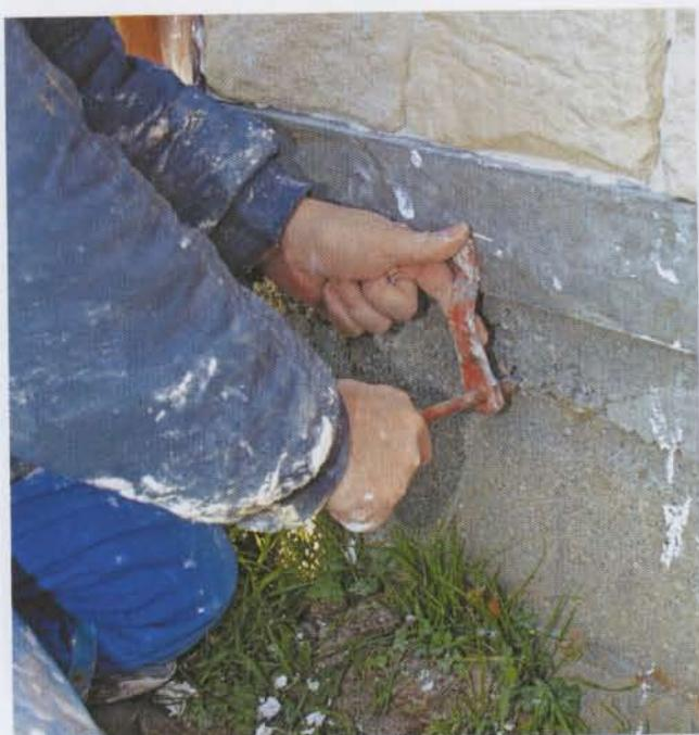
**16** Une règle est plaquée sur la partie basse du muret. Calée au niveau, elle sert de point d'appui à la maçonnerie de pierres reconstituées. La partie basse laissée en béton accueillera la terre des plates-bandes.
