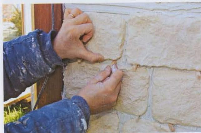
**19** En plus de clous servant à maintenir la plaque pour éviter qu'elle ne glisse vers le bas pendant le temps de prise du mortier, l'artisan unifie l'ensemble des joints de la maçonnerie à l'aide de cales en bois.
