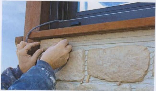
**23** Les gestes et le travail demandent pour la finition un peu plus de précision, mais avec un disque à matériaux ou un disque diamant le produit se coupe très facilement jusqu'à de faibles épaisseurs en prenant soin de sécuriser avec un chevron.
