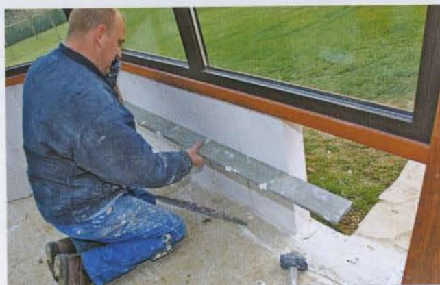
**10** La vérification de l'alignement des briques peut se faire à l'aide d'une règle, comme ici. On peut aussi les tirer au cordeau ou en s'appuyant sur un repère réalisé au sol à l'aide d'un marqueur.
