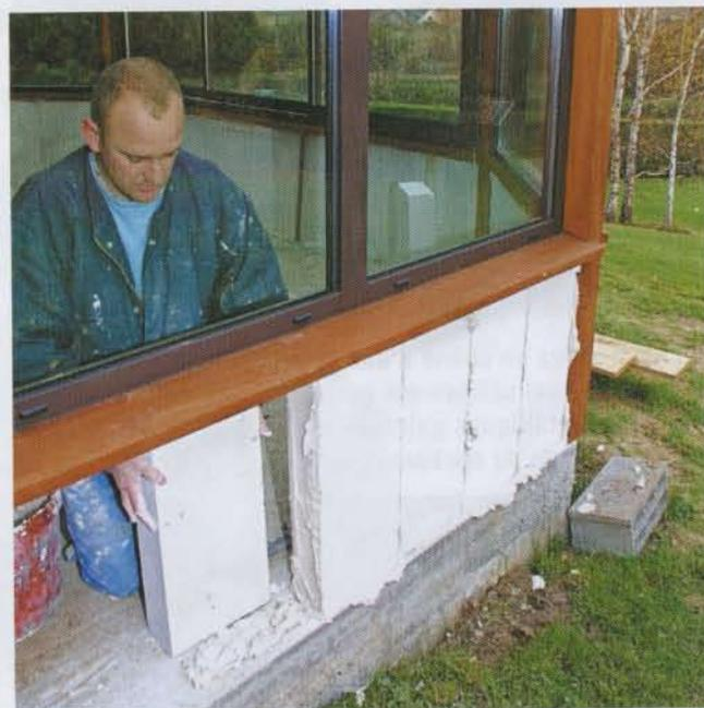
**9** Véritable jeu de construction, le système thermopierre démontre ici ses capacités d'être pour l'autoconstructeur à la fois un mur porteur et son isolation, s'ajoutant à la simplicité de la mise en œuvre.
