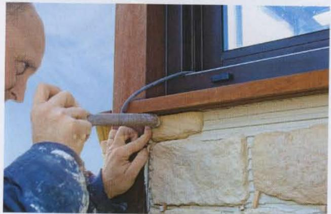
**24** Le poseur ajuste le petit morceau de plaque, préalablement découpé, à l'aide du manche en bois de son marteau. Le temps de prise du mortier permet sans souci d'ajuster finement les divers éléments constituant l'ensemble du parement.
