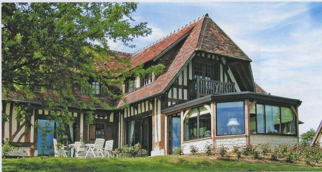
La solution retenue est cette véranda à ossature bois (Normandie oblige) associée à une fabrication soignée de doubles vitrages sur structure d'aluminium menuisé à une ossature de chêne massif.
