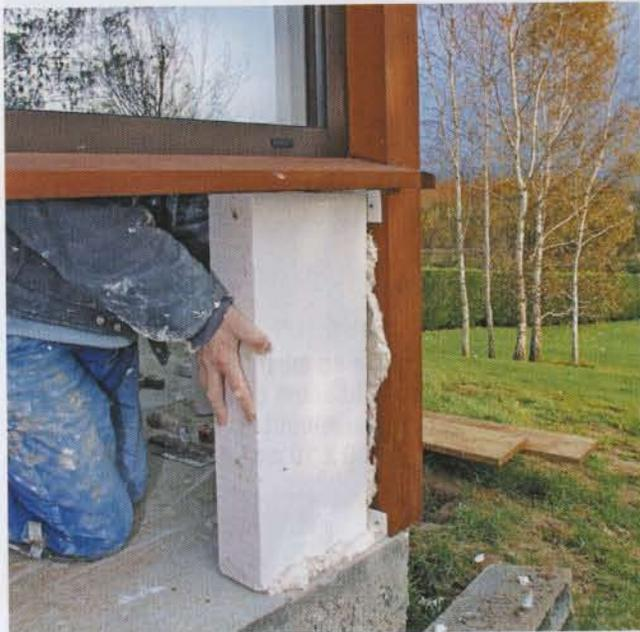
**6** Le gros plan montre l'épaisseur des joints qui est relativement faible : il ne faut pas compter rattraper un défaut de coupe. Les briques doivent être ajustées le mieux possible.
