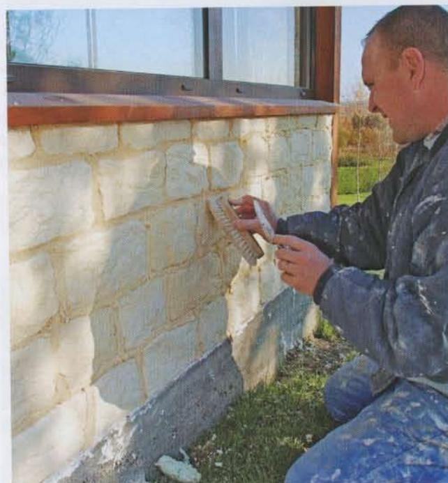
**29** Le rythme de pose est harmonieux, l'alignement des pierres est évité car on a mélangé les tailles des pierres dans chaque rangée. Prendre soin, lors de la coupe, d'arrondir les angles afin d'éviter les arêtes vives.
