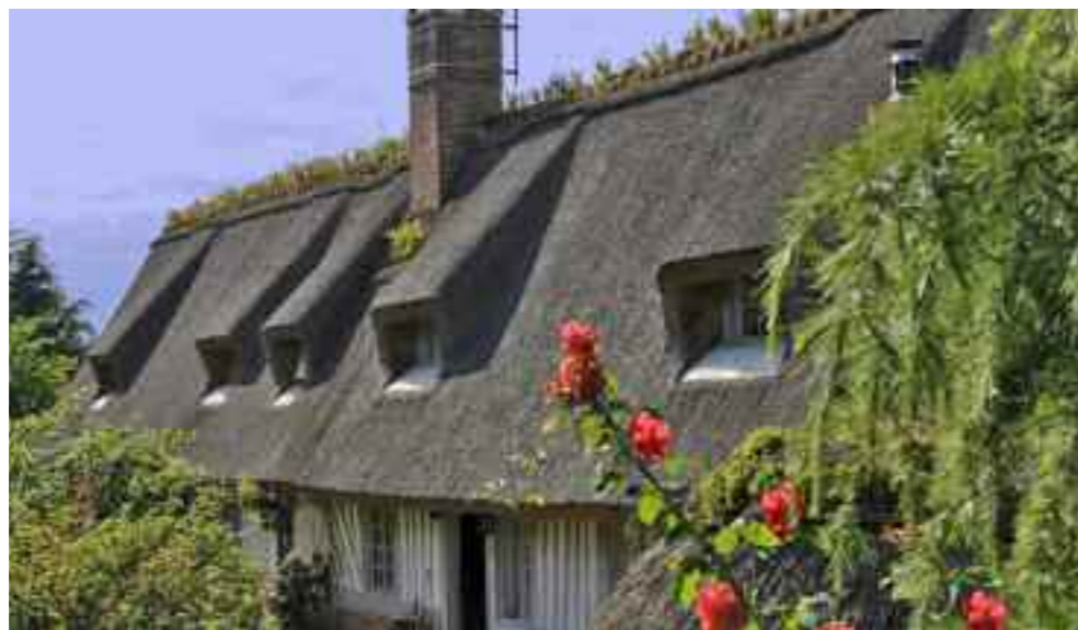
Les 400 m2 de toiture de cette chaumière normande d'époque 18ème viennent d'être remis à neuf. À noter la pente du toit ; au moins 30% et le charpentage nécessaire des lucarnes accolé au faitage.
